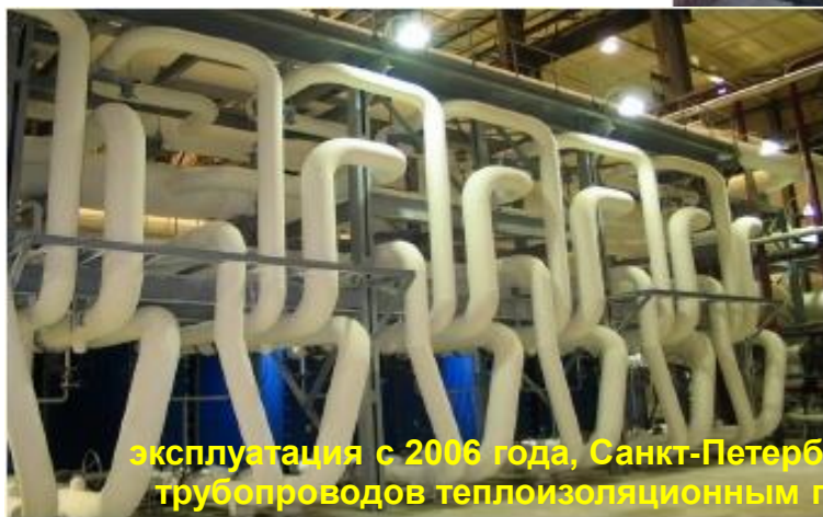
"традиционная" теплоизоляция - эксплуатация 4 года .....
