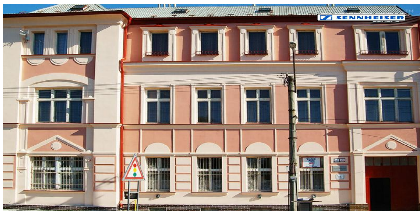
фасад обработан сверхтонким теплоизоляционным покрытием, финишный слой - фасадные краски
